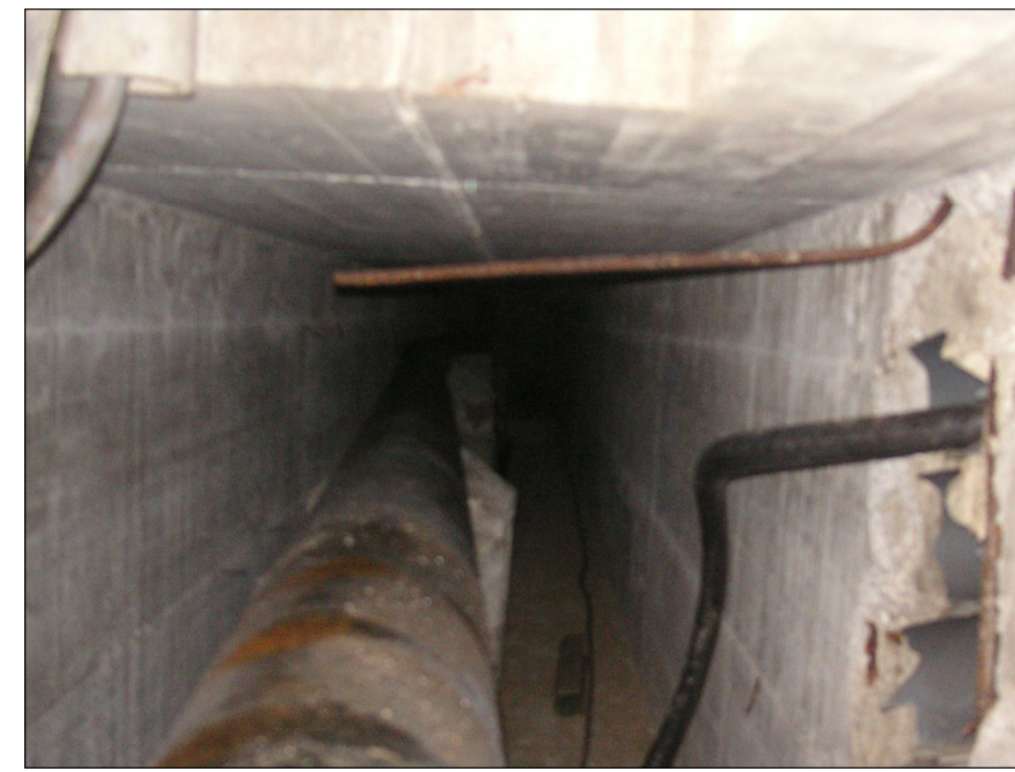
CUNICOLO DI PROTEZIONE ESISTENTE IN C.A.
